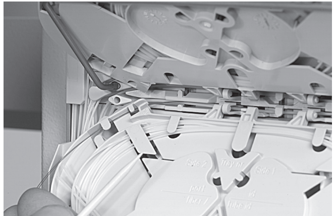
5.5 Fasern aus den Bündeladern (Kabelseite) ebenso in die Nut direkt unter der Kassette einlegen. Darauf achten, dass sich alle Fasern unter den Führungsnasen befinden.
