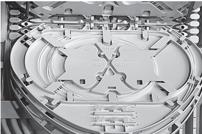
5.3 Die Ader wie abgebildet in die Nut einlegen und in der Mitte anzeichnen.
