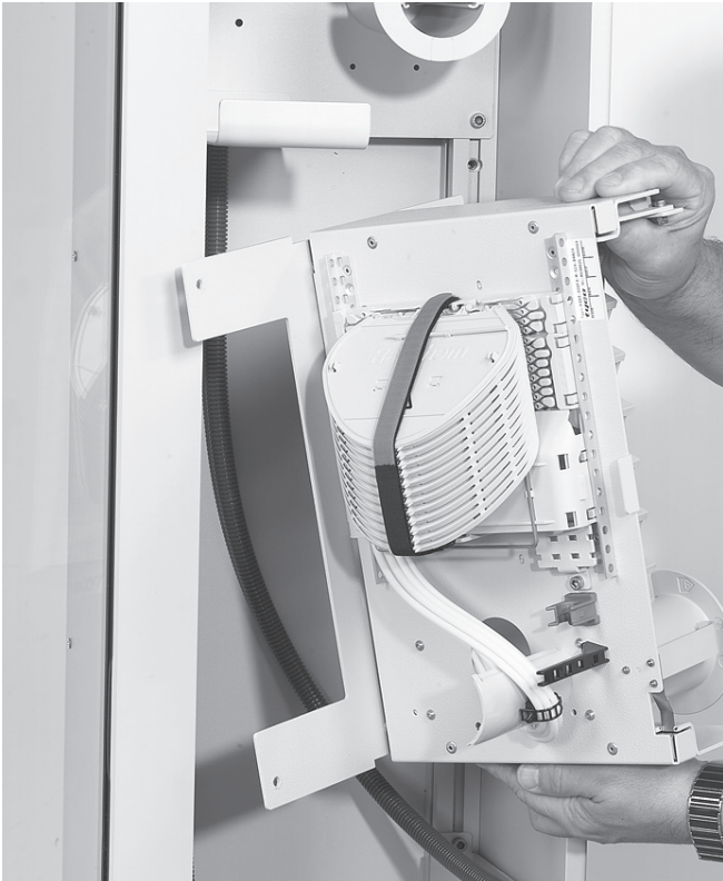
3.5 Das Modul, leicht angeschrägt, in das Gestell einbringen. Danach an den Profilen zur gewünschten Position schieben.
