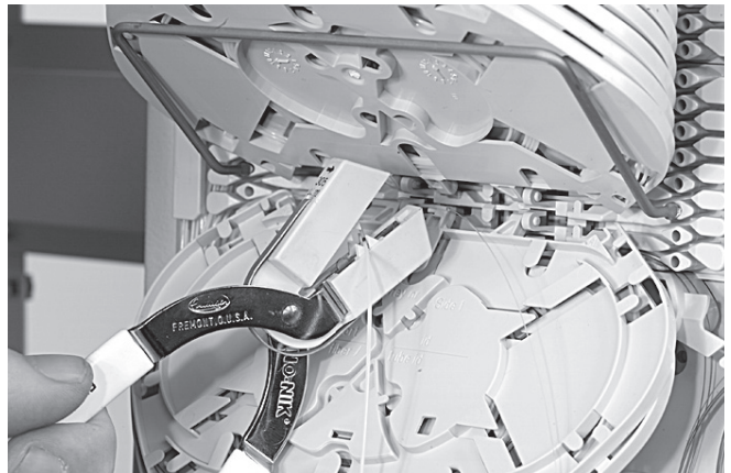
5.4 Die Ader mit entsprechendem Werkzeug absetzen. Dabei das Primärcoating (250µm) nicht beschädigen.
