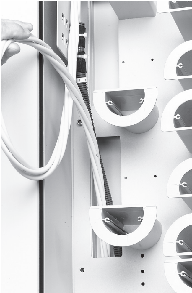
4.3.4 Die IFC-Elemente, durch die Öffnung der Spindelplatte, zum gewünschten Modul fädeln.
