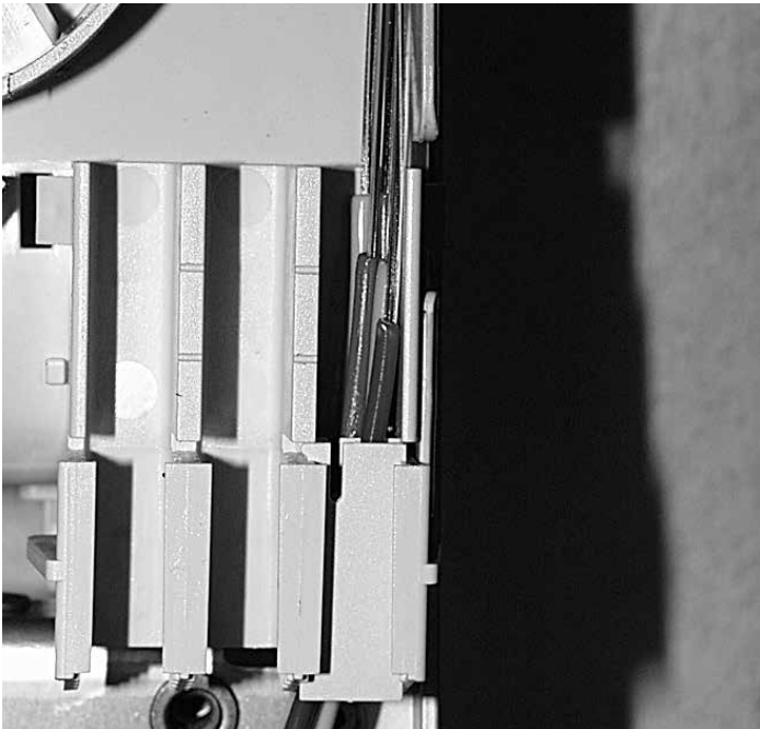
5.5.4.4 Abgesetzte und gereinigte Bündeladern und Fasern in einen der Führungskanäle legen und mit Bündelader Niederhalteplättchen fixieren.
