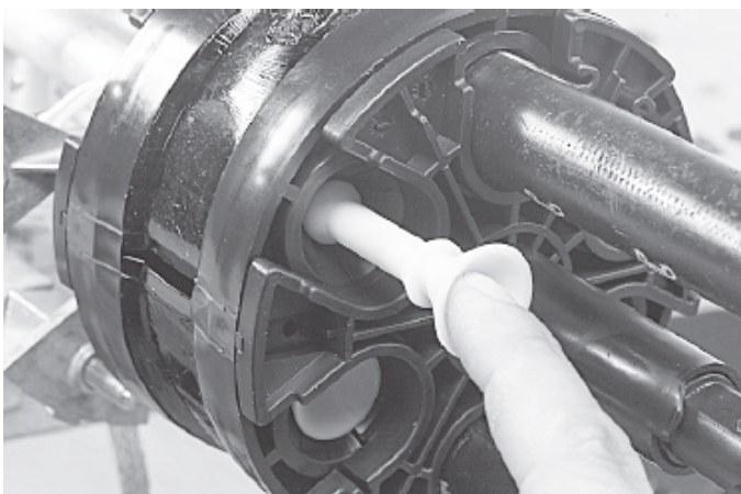
5.3.2 Vor dem verschließen Dichtflächen auf Verschmutzung prüfen. In die nicht belegten Einführungen, Füllstopfen einlegen und darauf achten, dass die Kunststoffkronen des Gelblocks nicht umgebogen werden.
