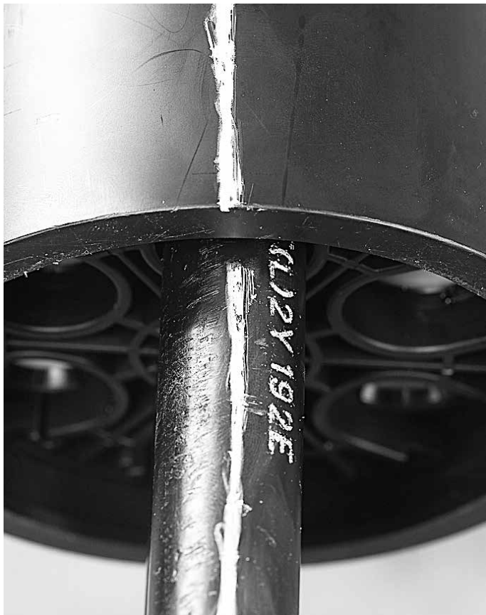
5.3.6 Längsmarkierung auf Kabel und Kabeleinführungsröhr anbringen. Wichtig: beim Ablegen und Bewegen der Muffe müssen die Striche immer in einer Linie sein.
